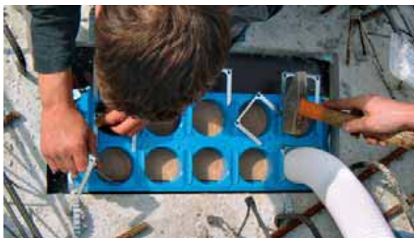
Abbildung 10: Installation der Easy-Flexschläuche an der Montageplatte
