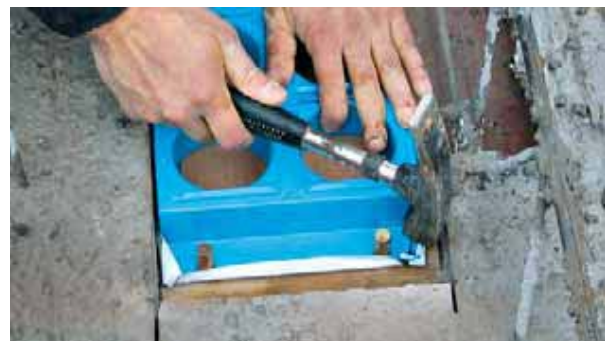
Abbildung 6: Fixierung der Montageplatte
