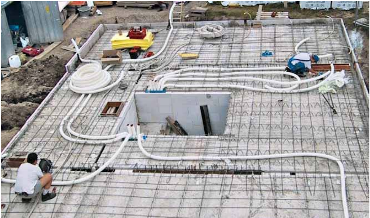
Abbildung 1: Aussparung in der Schalung für Montageplatte
