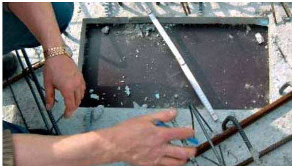
Abbildung 2: Aussparung in der Schalung für Montageplatte
