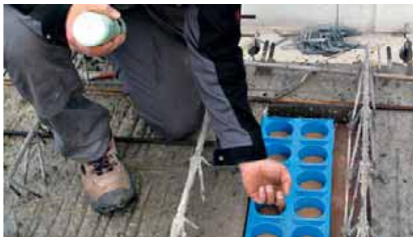
Abbildung 9: Gleitmittel zum einfachen Einstecken der Rohre verwenden
