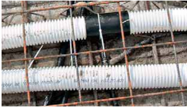
Abbildung 7: Verbindelement zur verschmittlosen Verarbeitung des Easy-Flexschlauches
