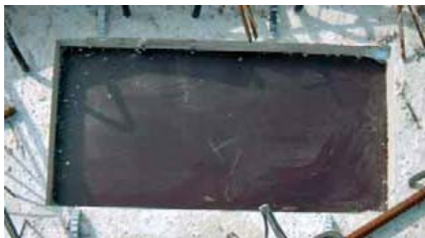
Abbildung 4: Vorbereiteter Installationsbereich der Montageplatte (gereinigt)
